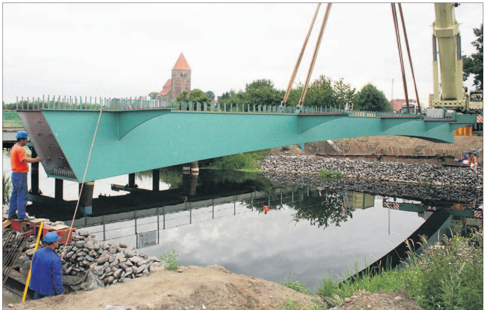
Drei dieser Stahlhauptträger wurden für die neue Trebelbrücke in Tribsees eingesetzt.
